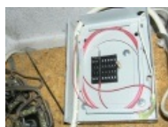
Оптическая распределительная коробка без крышки
